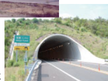
近畿自動車道塩屋工事
